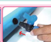
นำข้อต่อหรือวาล์วสำหรับต่อท่อ พีวีซีมาสวมเข้าไปที่ลูกยาง D-GR
